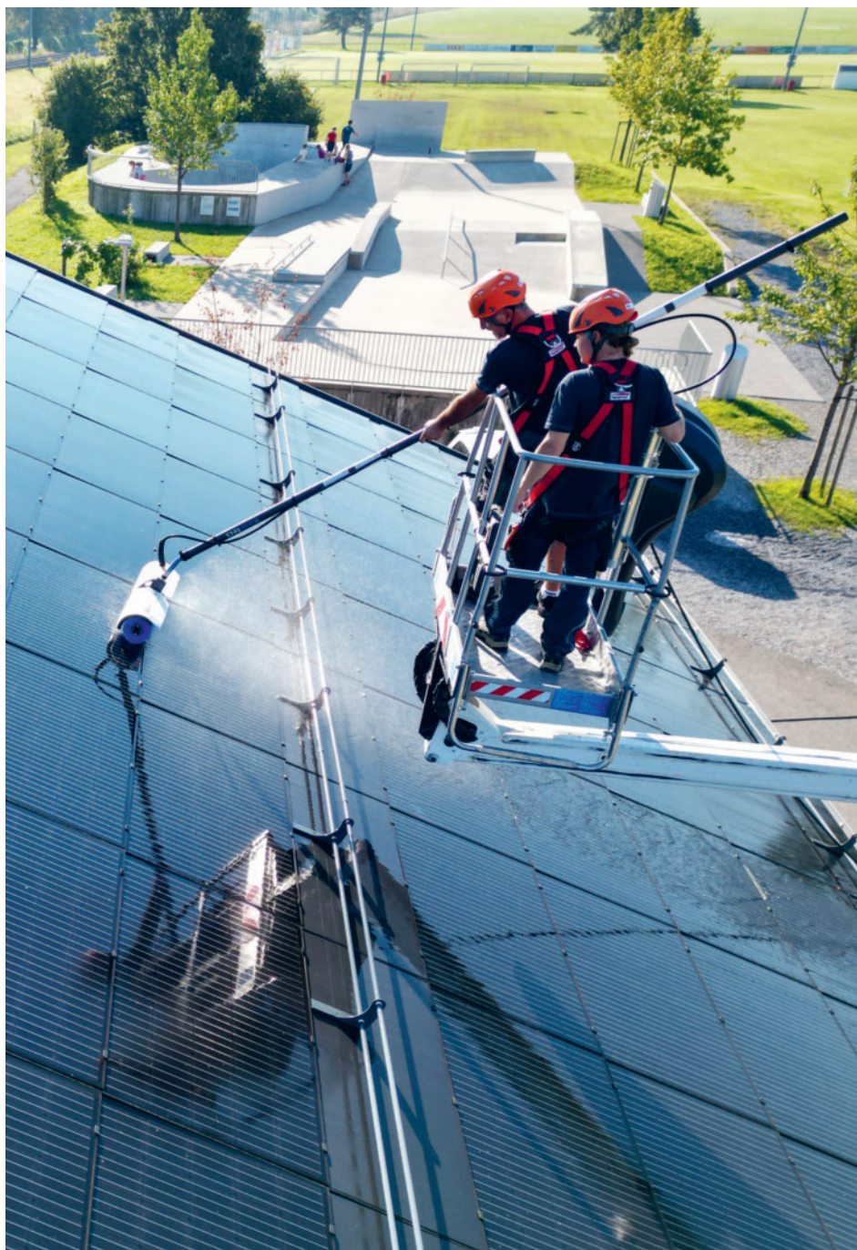
Mit einem Spezial-Equipment reinigt die EWU AG Panels.
