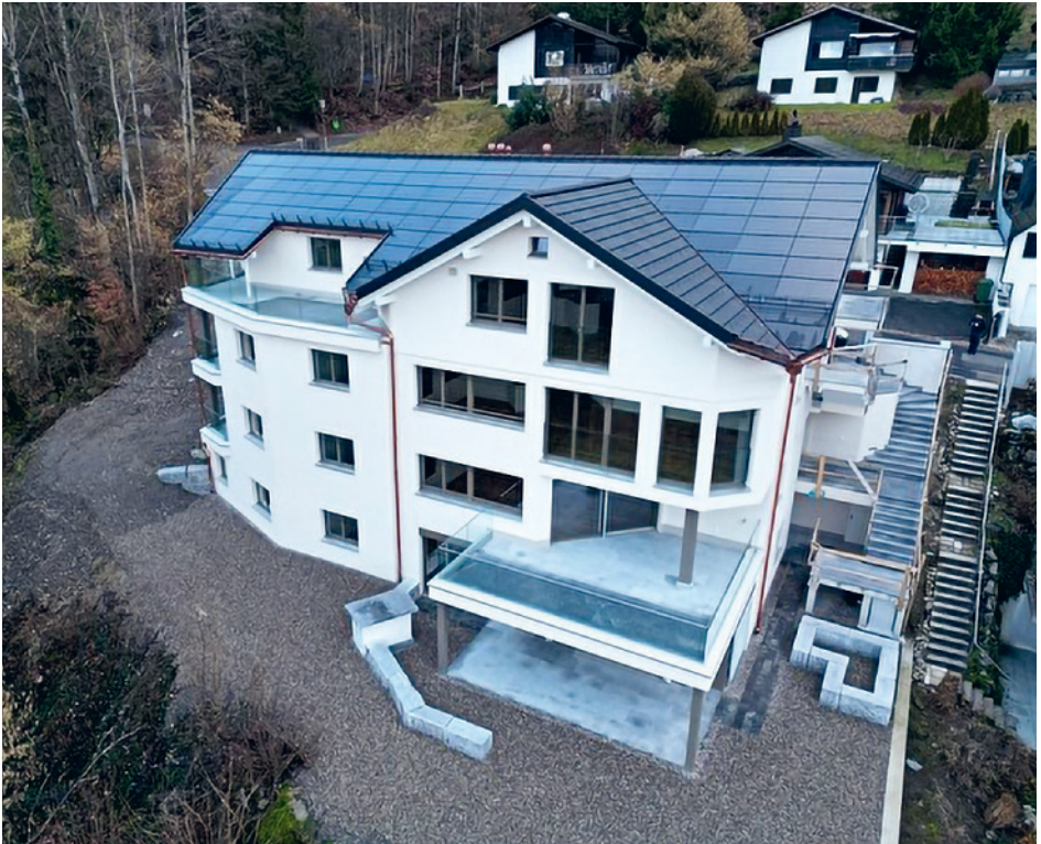
EWU realisierte Elektroinstallation und PV-Anlage als Gesamtprojekt im Haus Novem Vista in Uetliburg.
