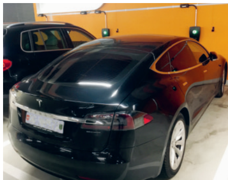
In der Tiefgarage Spital Linth sind zehn Parkplätze mit Ladestationen ausgerüstet.
